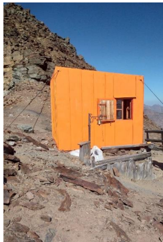
(Il bivacco dopo la riverniciatura del settembre 2023)
